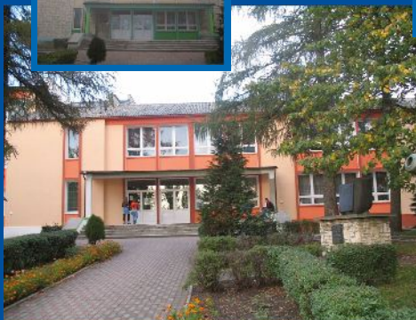
Termomodernizacja - Szkoła Podstawowa w Uniejowie
