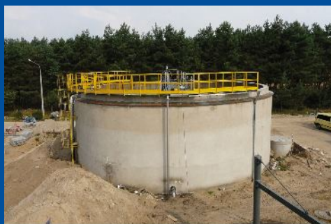
Budowa oczyszczalni w Uniejowie
