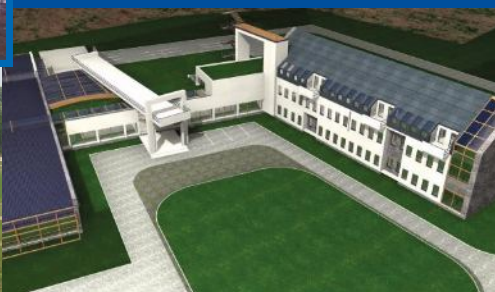
Budowa Hotelu "Lawendowe Termy"
