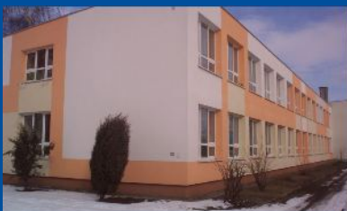
Termomodernizacja - Szkoła Podstawowa w Wilamowie
