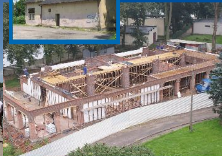
Restauracja budynku po byłym kinie na Dom Pracy Twórczej ASP w Łodzi
