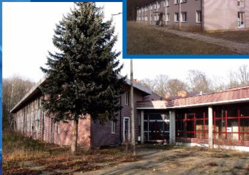
Budowa Sanatorium "Uniejów" (Instytut Zdrowia Człowieka)
