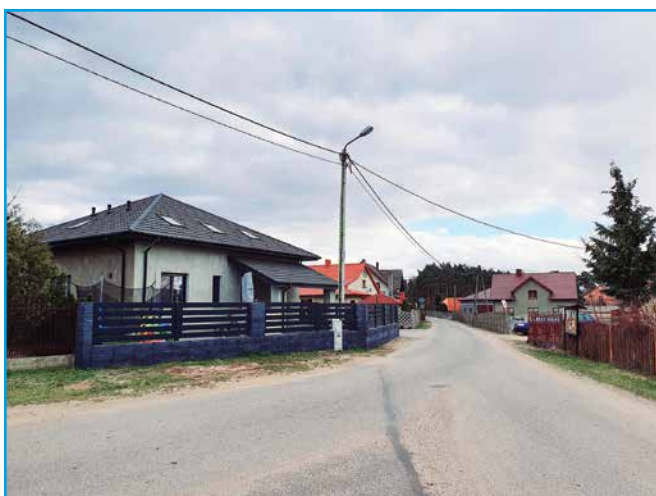
Główna droga asfaltowa biegnąca przez wieś (fot. Andrzej Zwoliński)
