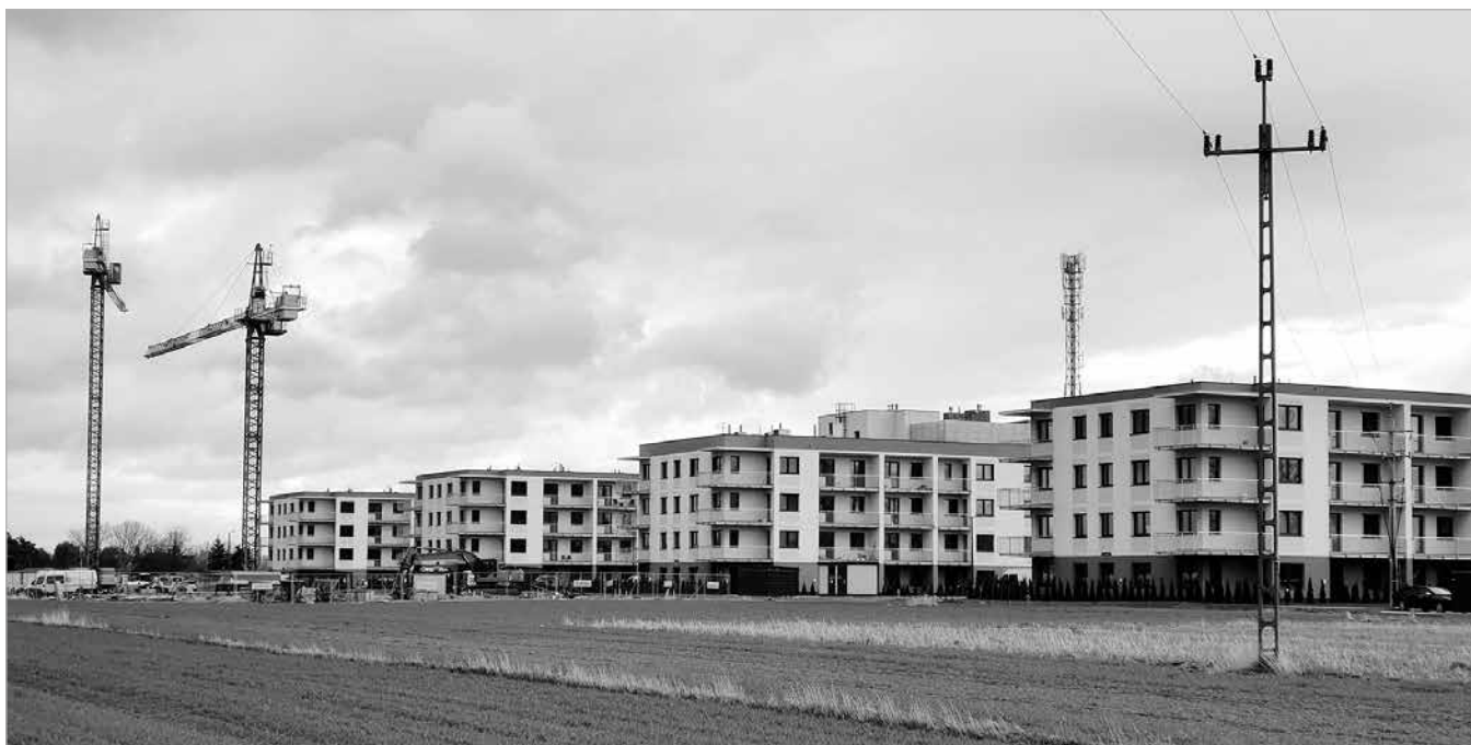
Obok oddanych do użytku nowych bloków powstaje plac budowy trzech następnych (fot. Andrzej Zwoliński)
