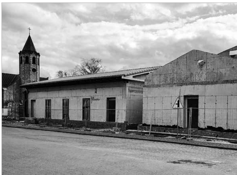
Z placu budowy Centrum Historyczno-Kulturalnego w Spycimierzu (fot. Andrzej Zwłóński)
