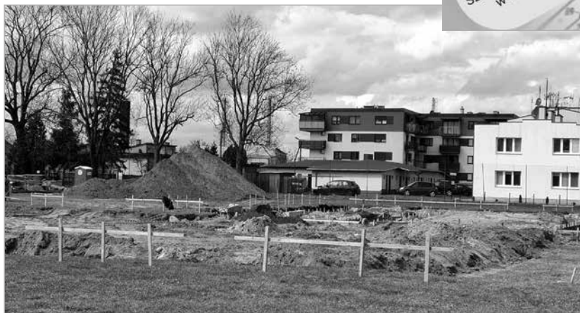
Budowa przedszkola stała się faktem (fot. Andrzej Zwłóński)
