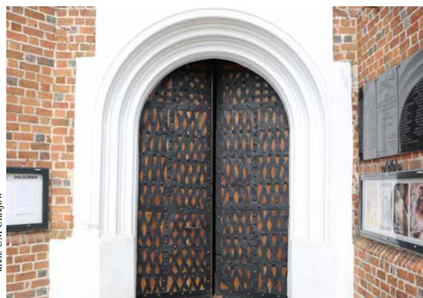
Drzwi po renowacji
