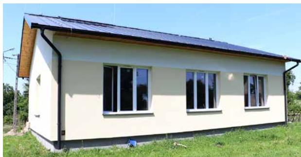
Remontowana strażnica w Woli Przedmiejskiej
