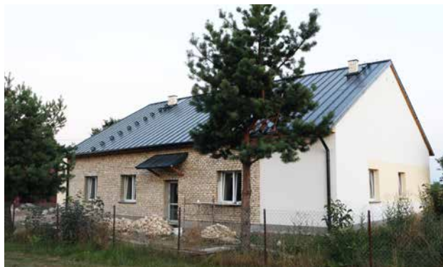
Remontowany obiekt użyteczności publicznej w Skotnikach
