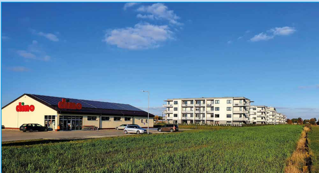
Październik 2022 - W dali 5 zamieszkałych już nowoczesnych jednoklatkowych bloków z windą, a na pierwszym planie market DINO wpisujący się w nową infrastrukturę. Droga między ul. Targową a Dąbską uchwałą Rady Miasta została mianowana ul. Długą. Za oddanymi do użytku blokami przy ulicy Długiej trwa budowa trzech kolejnych (fot. Andrzej Zwoliński)
