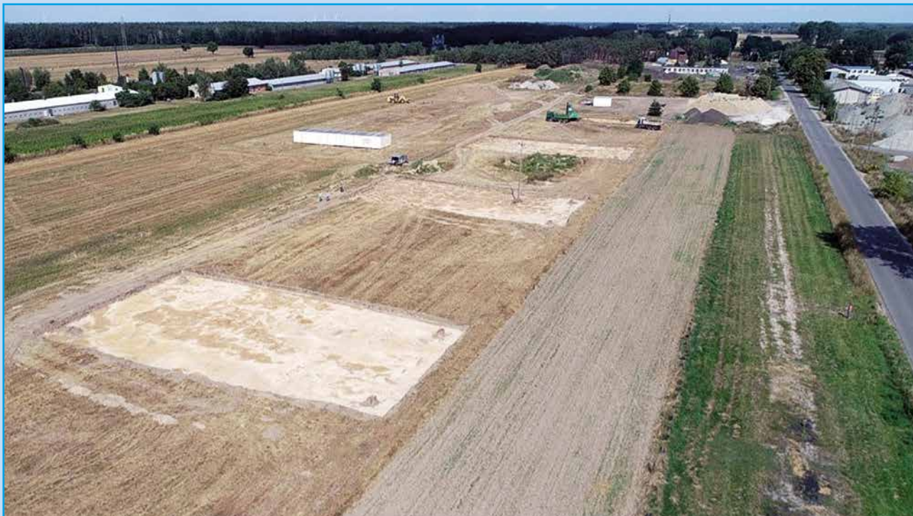
Rok 2020 - teren wzdłuż drogi łączącej ul. Targową z ulicą Dąbską, przygotowany pod budowę nowych bloków (fot. Urszula Urbaniak)
