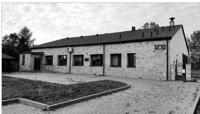
Frontowa ściana i otoczenie wyremontowanej strażnicy OSP (fot. Andrzej Zwoliński)
