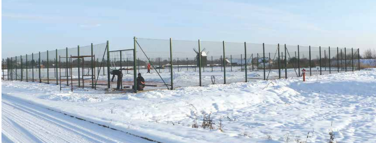
Montaż ogrodzenia kortów
