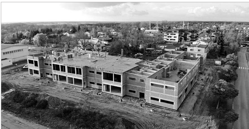
Przedszkole w budowie - widok z lotu ptaka, stan z początku listopada 2022 (for. arch. Urzędu Miasta)
