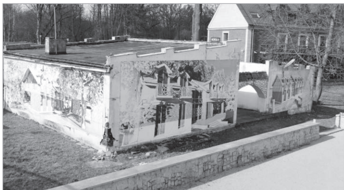
Posterunek wodny przed rozbiórką ( www.poddebice.nasze_miasto.pl )
