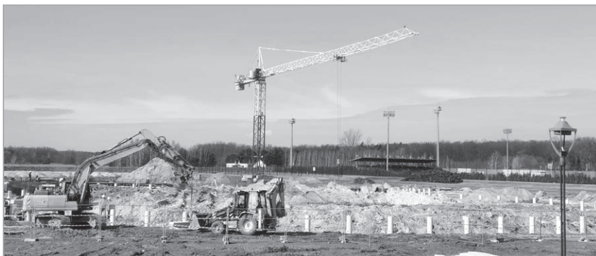
Plac budowy między kompleksem boisk piłkarskich a Zagrodą Młynarską (fot. Andrzej Zwoliński)
