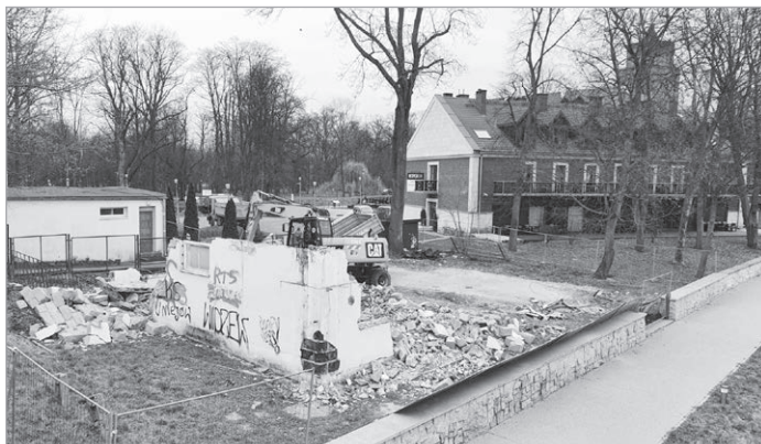
Miejsce rozebranego posterunku wodnego będzie wkrótce placem budowy do realizacji nowego obiektu - Punktu Turystyki Geotermalnej w Uniejowie (fot. Andrzej Zwoliński)
