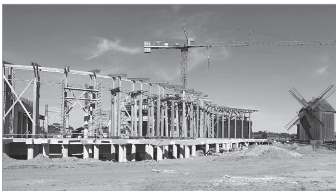
Stan zaawansowania budowy tężni (fot. Andrzej Zwoliński)
