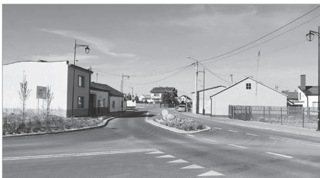
Przebudowa skrzyżowania była pierwszą inwestycją realizowaną w ramach projektu pn. „Zielony Uniejów – Thermal Resort”. (fot. Andrzej Zwoliński)
