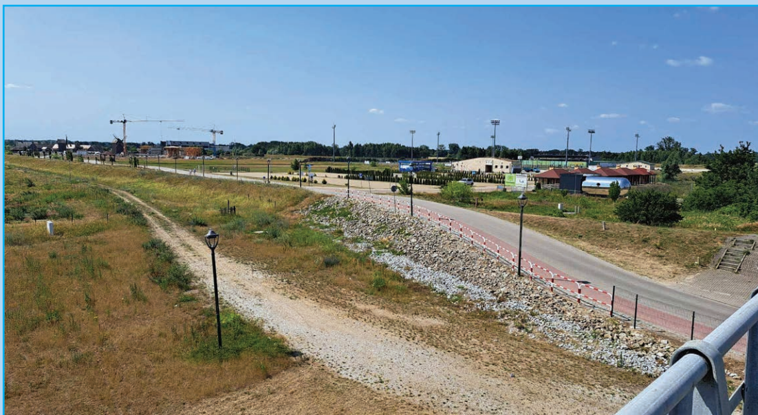
Inwestycje w miejscu dawnych łąk, przyczyniające się do rozwoju miasta, podlegające administracyjnie PGK „Termy Uniejów”: Kompleks Boisk Piłkarskich, Zagroda Młynarska, obecnie budowane tężnie. Jest tam również prywatna inwestycja Medical Spa Hotel ****Lawendowe Termy (fot. Małgorzata Wojtasiak)
