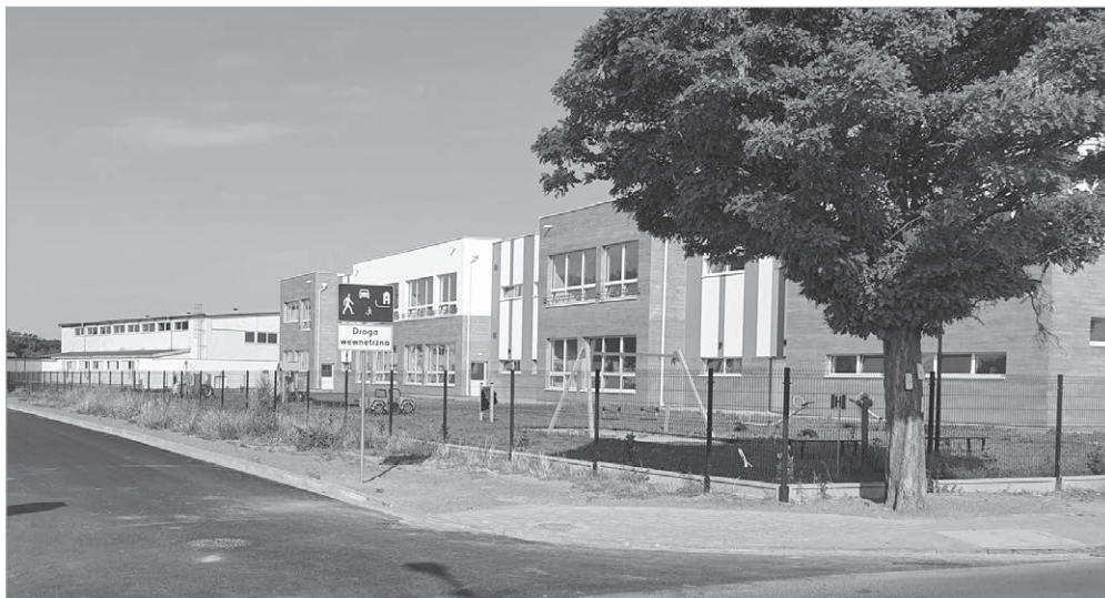
Droga dojazdowa przygotowana, teren wokół zagospodarowany, trwają prace wewnątrz budynku przedszkola ( fot. Andrzej Zwoliński)
