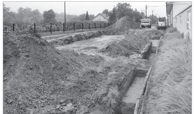
Prace na ul. Kościelnickiej (fot. Andrzej Zwoliński)
