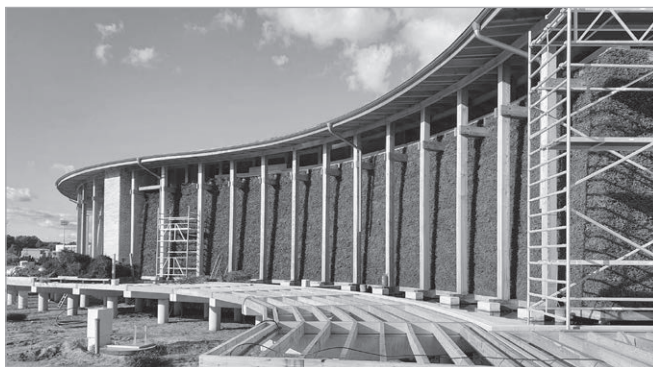
Obecny stan zaawansowania budowy tężni (fot. Andrzej Zwoliński)
