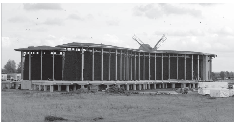
Tężnia w budowie (fot. UM w Uniejowie)
