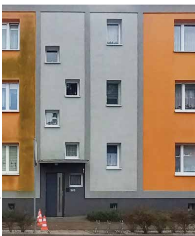
Elewacja bloku w trakcie czyszczenia
