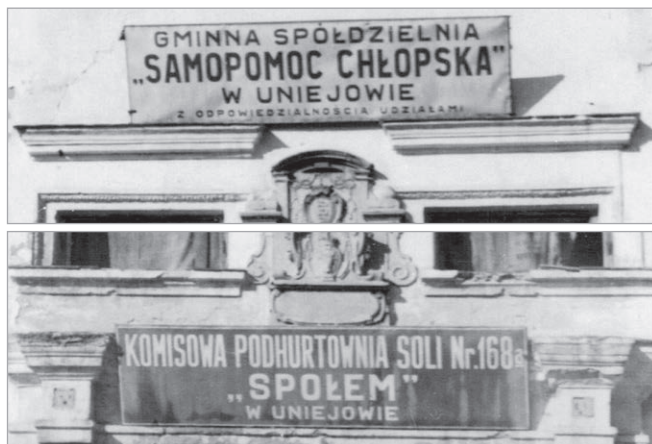
Sztyldy użytkowników pomieszczeń zamkowych w pierwszych latach po wojnie (ze zb. Jerzego Kaszyńskiego)
