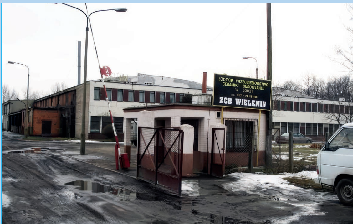
Lata 90. XX wieku – na terenie Zakładu Ceramiki Budowlanej w Wieleńinie-Kolonii. Zakład rozpoczął produkcję cegły w 1973 roku, a zakończył ją definitywnie po 32 latach działalności (fot. ze zb. Tomasza Wójcika)
