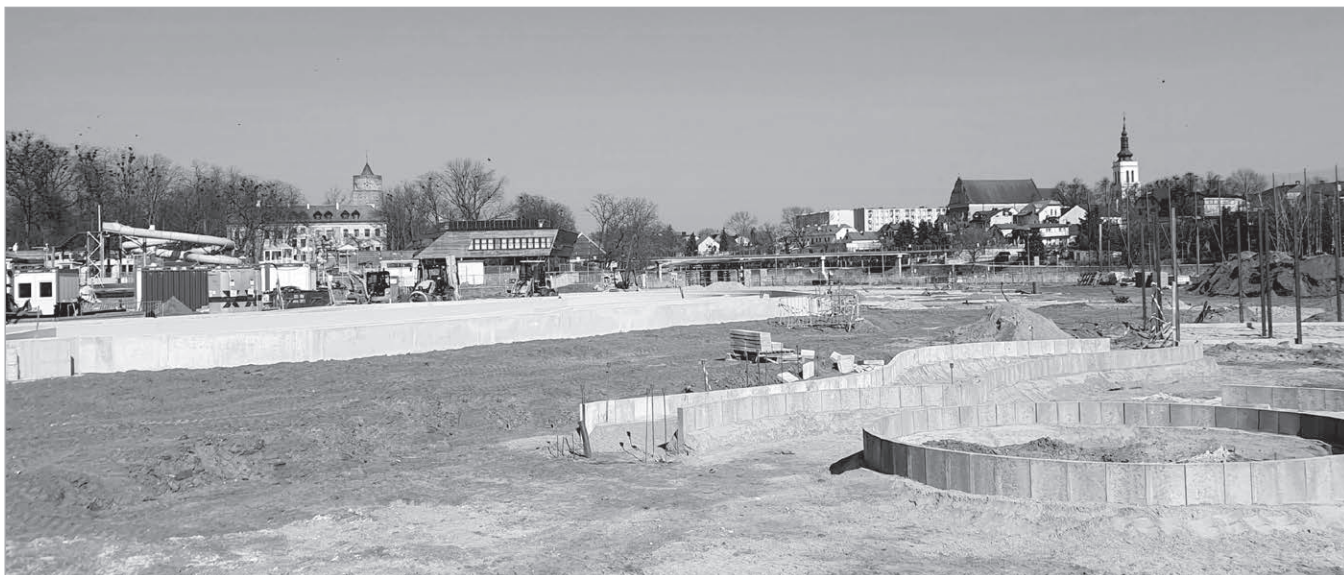
Nowa inwestycja w budowie (fot. Andrzej Zwoliński)
