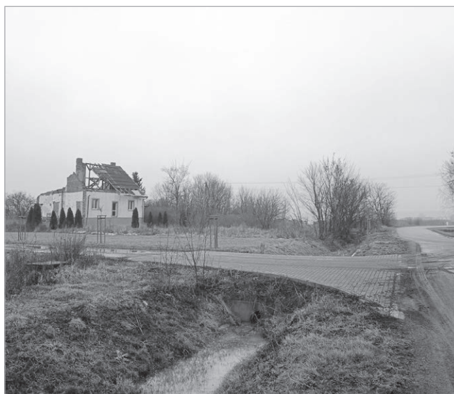
Stan obecny miejsca, w którym był folwark. Część przystosowana do zamieszkania została bez opieki po śmierci użytkowniczki. Czas i wichura (patrz na dach) zrobili swoje (fot. Dominik Wilmański)
